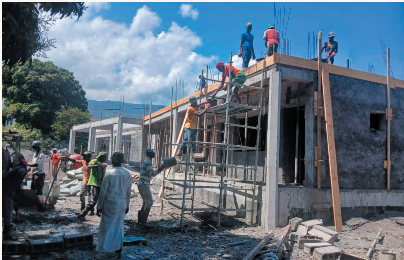
Construction du laboratoire d'analyse de l'eau
